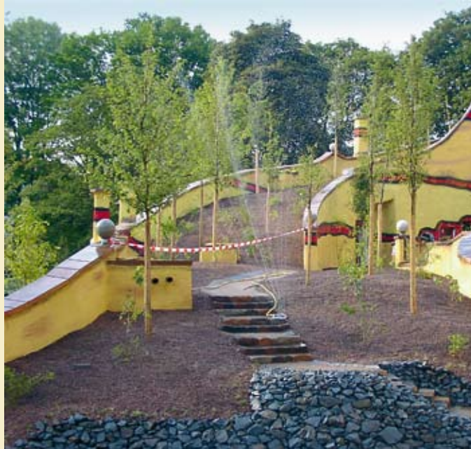
Referenz mit tollem Werbeeffect: fertiges Ronald McDonald Haus im Gruga-Park Essen (oben) und während der Bauphase
