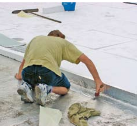
Kein Problem für den Dachdecker: Einbau einer Dampfsperre
