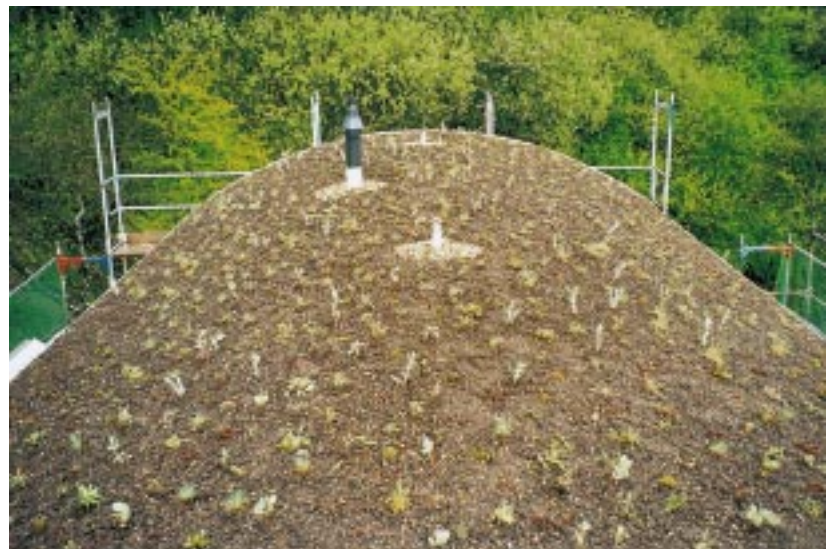
Die fertige Bepflanzung zeigt das zukünftige Gründach.
