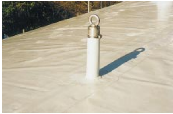
Der Anschlagpunkt für Absturzsicherung ist gut sichtbar.
